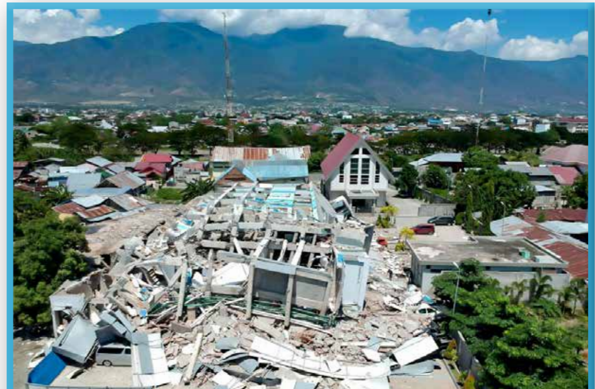
Bangunan hotel 10 tingkat runtuh sepenuhnya selepas gempa di Palu.
