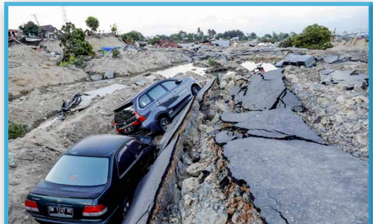
Kenderaan-kenderaan terperangkap di atas jalan yang retak dan mendap akibat gempa.
